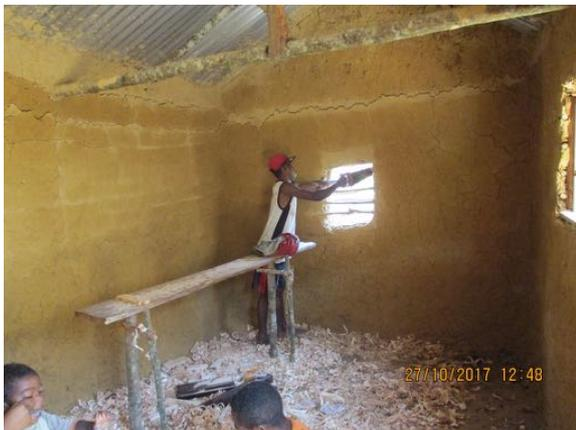
*Figura 5 In alto l'interno della capanna in costruzione. A destra si monta la porta in legno.*
